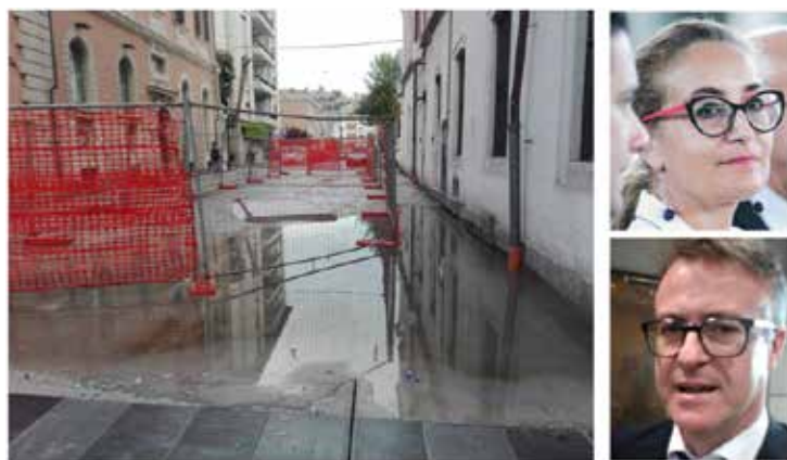
La "piscina" della Prefettura in via Irelli. A destra, l'assessore Di Padova e l'architetto Vallese
